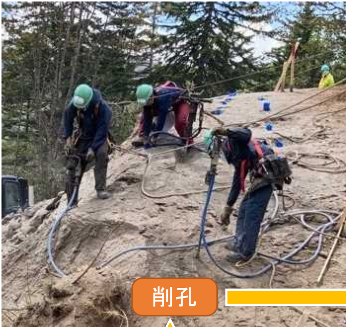
崩落土の処理
